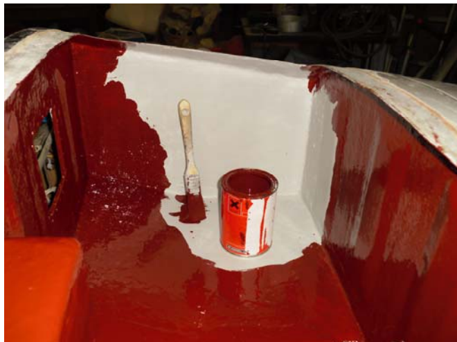
Tankbeschichtung mit KREEM ROT
