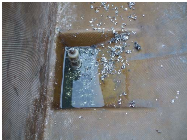
Der Tanksumpf nach dem Aufschneiden
